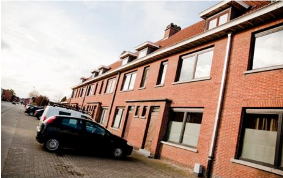
Site van Sint-Gillis-Waas, bestaande uit eengezinswoningen
