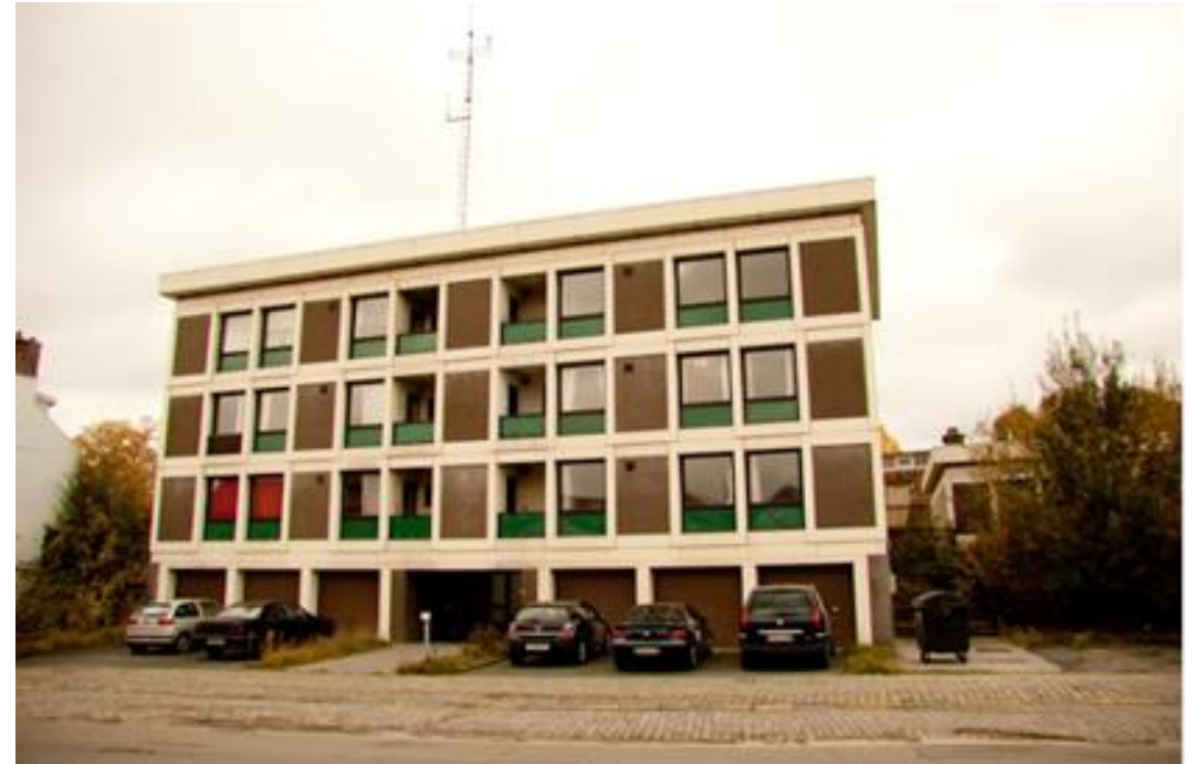
Site van Tubeke, bestaande uit 7 appartementen
